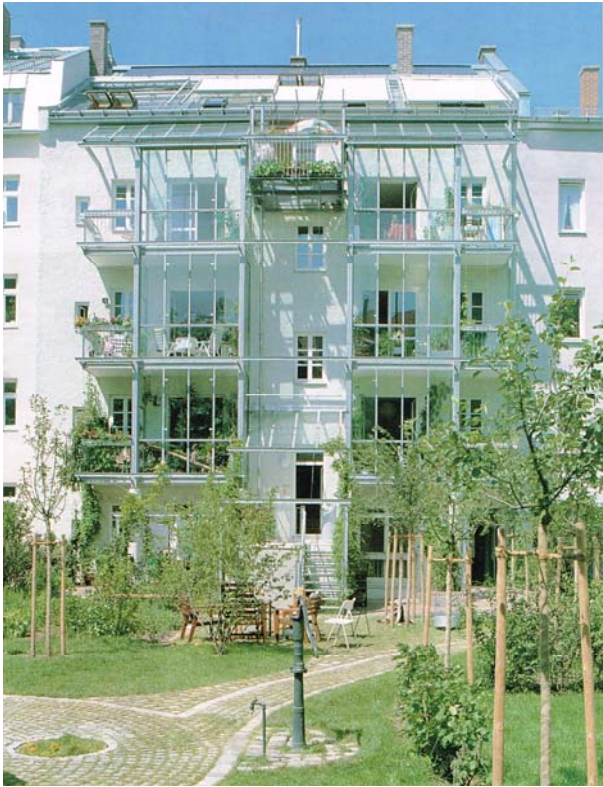
写真-8 建物に鉄骨とガラスのサンルームの増設と同様にエレベーターを増設するのは容易にイメージ出来る
